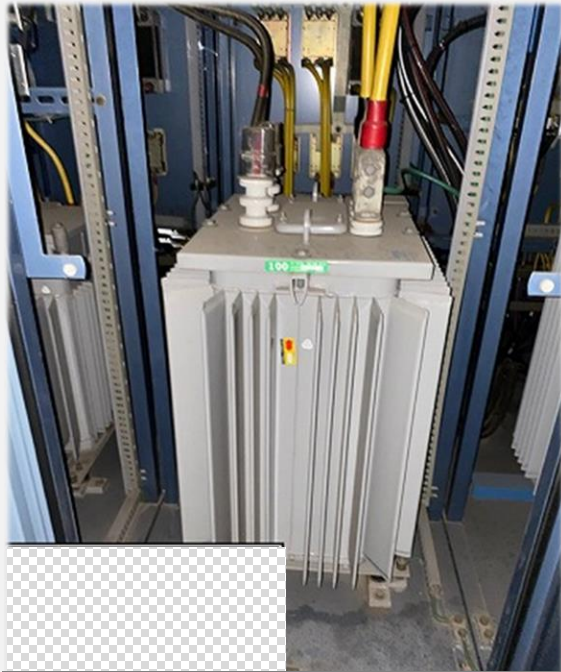
トランス100Kv 施工前
