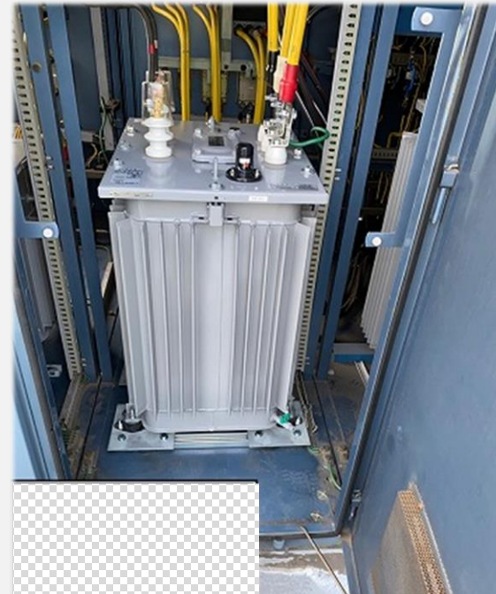
トランス100Kv 施工後
